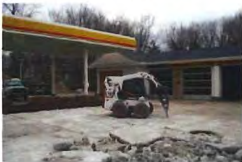
Rotura de loza y asfalto
