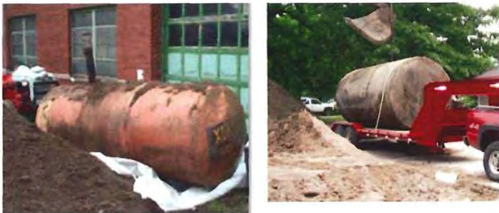
Ubicación de tanque removido fuera de la fosa
