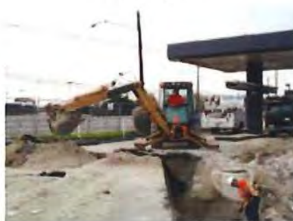
Descubrimiento líneas y accesorios del tanque
