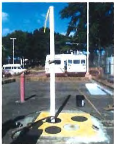
Desgasificación del tanque
