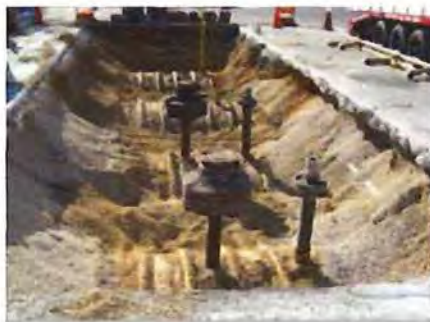
Descubrimiento parte superior del tanque
