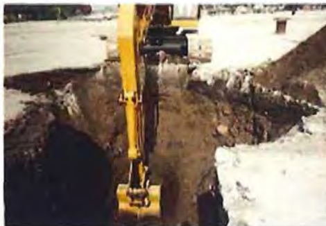
Extracción de suelo de la fosa
