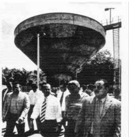
El agua que se instalará en los sectores altos de los municipios de Aguadilla, Maunabo y Culebrinas, saciará la sed de 20,000 familias.
