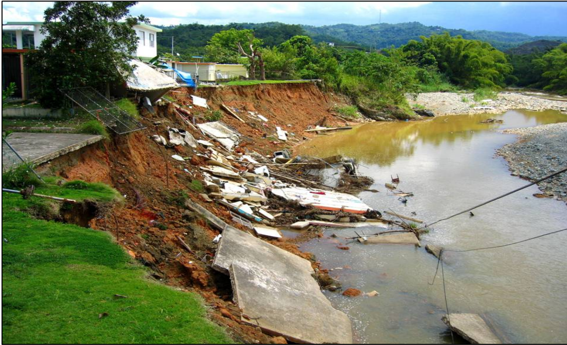
Ilustración 6.13 Deslizamiento de residencias a consecuencia de la erosión de la ribera del Río Turabo, Caguas
