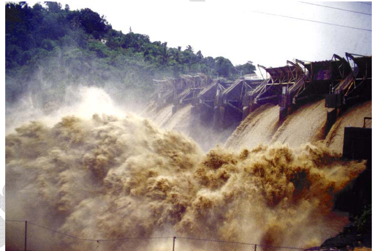
Figura 2-13. Las compuertas del embalse Loíza (Represa Carraízo) se abren luego de las intensas lluvias durante el Huracán Hortense, 1996 (foto por Mathew Larsen, USGS, 1996).
